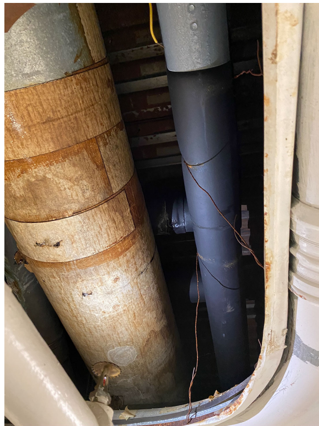
TYP BASEMENT CONDITION (2).JPEG
