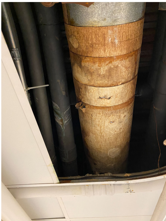
TYP BASEMENT CONDITION (3).JPEG
