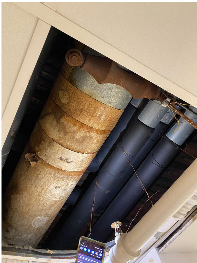
TYP BASEMENT CONDITION (1).JPEG
