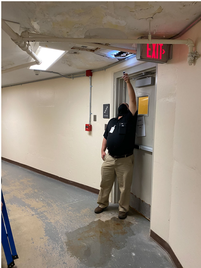
TYP BASEMENT CONDITION (5).JPEG
