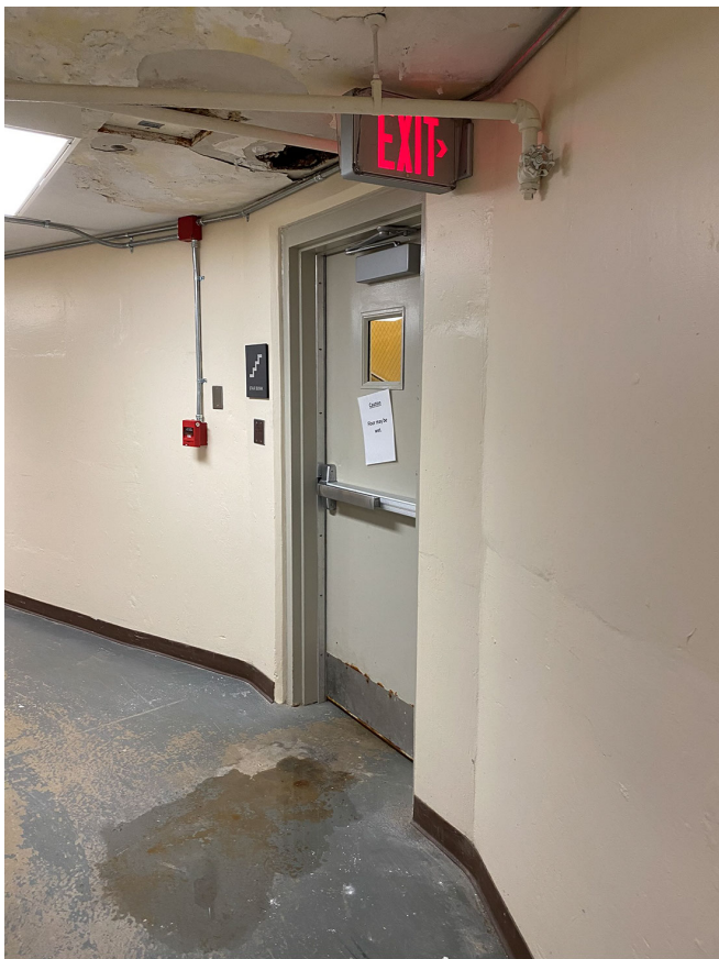
TYP BASEMENT CONDITION (7).JPEG
