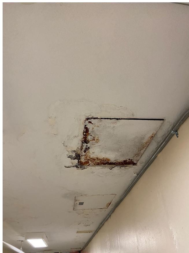
TYP BASEMENT CONDITION (4).JPEG
