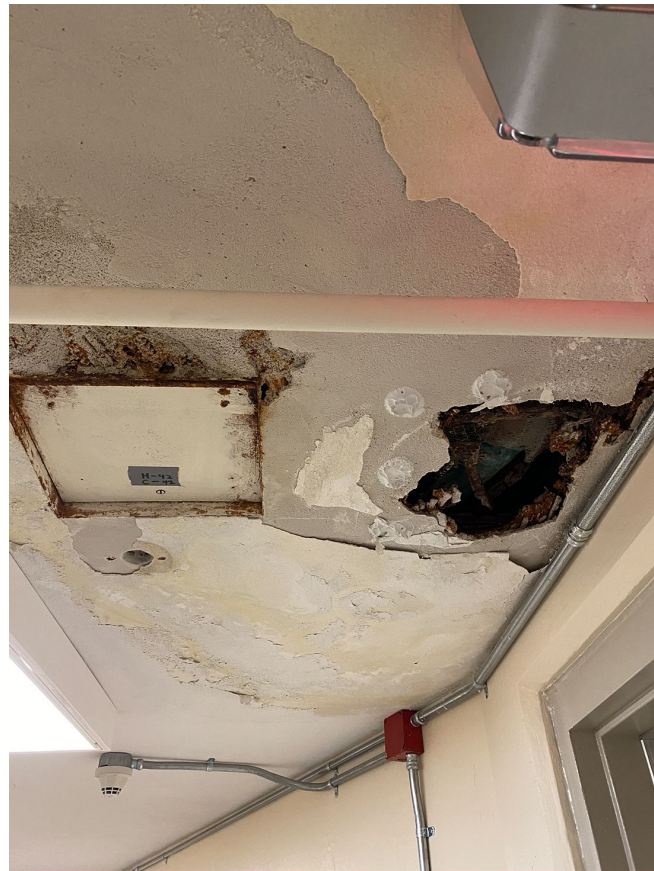
TYP BASEMENT CONDITION (6).JPEG
